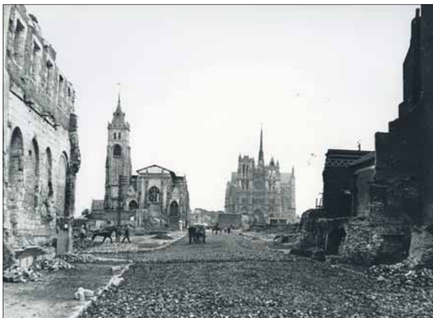
Dans la ville détruite, la cathédrale (au fond à droite) a été « miraculeusement » préservée.
