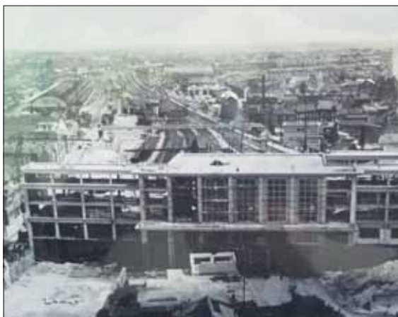
Le bâtiment de la gare SNCF en construction.
