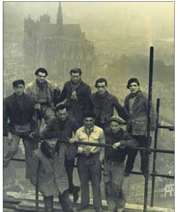
les ouvriers en haut de la tour avec, en bas à gauche, Jacques Bellina, le chef de chantier.
