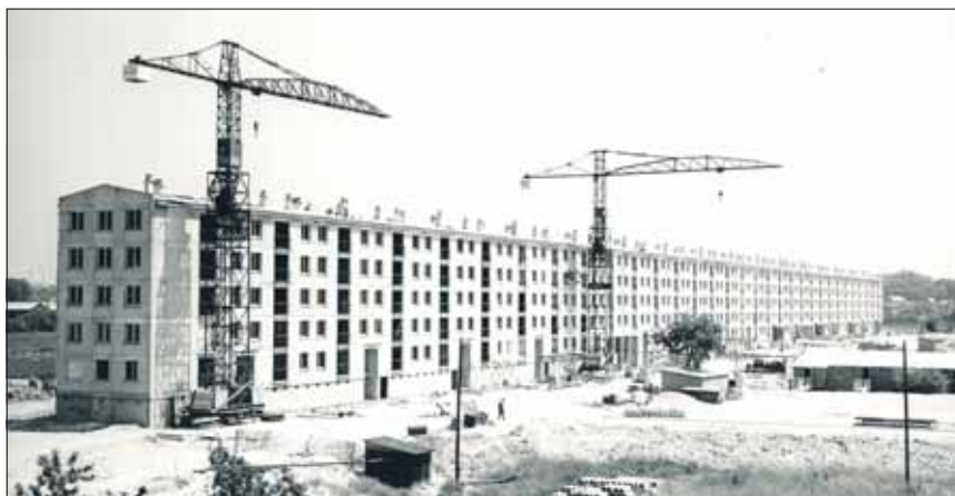
Construction des immeubles d'Etouvie.
