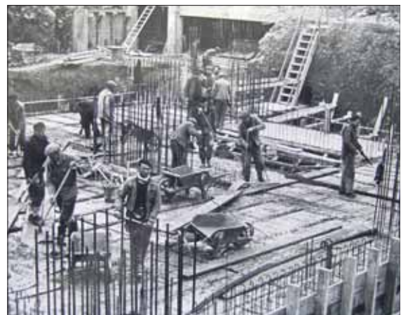
Pendant les travaux des fondations de la tour.
